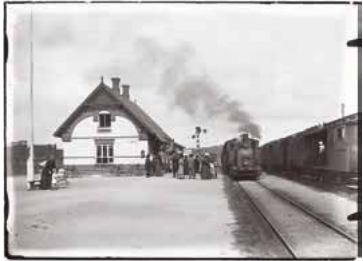
Bagsværd's første stationsbygning ca. 1907. Foto: Det kgl. Bibliotek.
